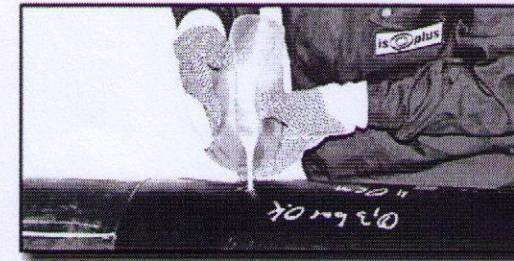
Die Schaumeinfüllöffnung unverzüglich mit einem schlagbaren Entlüftungsstopfen verschließen (10), vgl. (22.).
