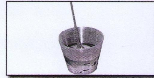
Nun die notwendige Schaummenge über die Einfüllöffnung komplett in die Muffe gießen.
